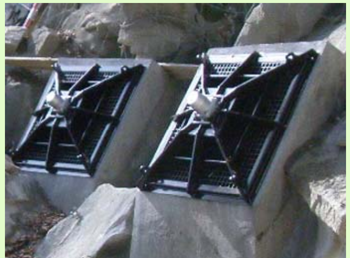
写真3：受圧板設置完了
