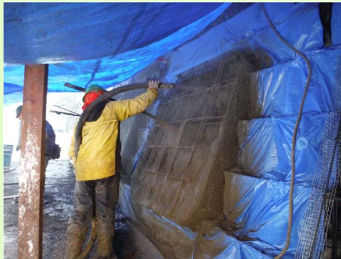
写真2：モルタル吹付状況
