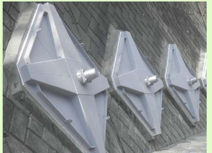
写真3：受圧板設置完了
