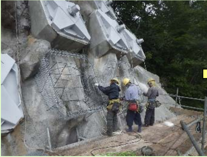
写真1：エフケー不陸調整枠設置状況
