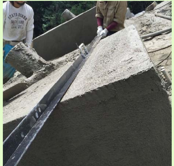
写真2：専用定規材による表面コテ仕上げ状況
