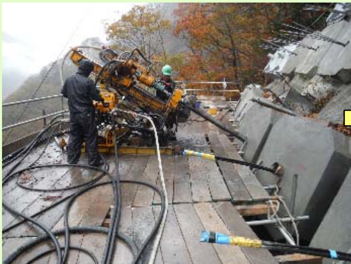
写真5：グラウンドアンカー施工状況
