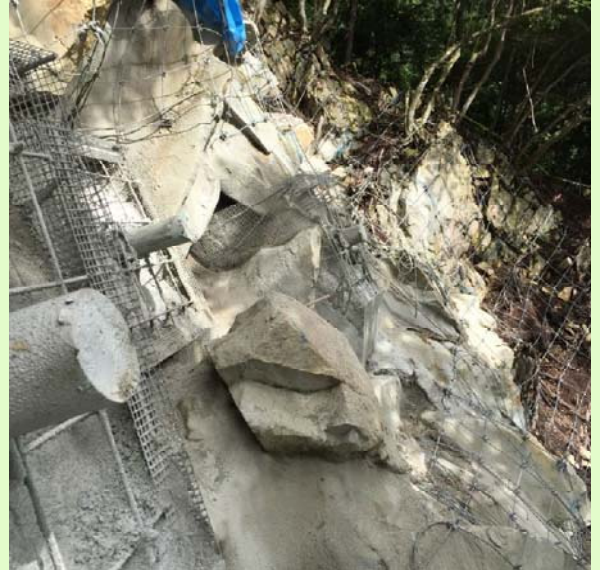
写真1：エフケー不陸調整枠設置
