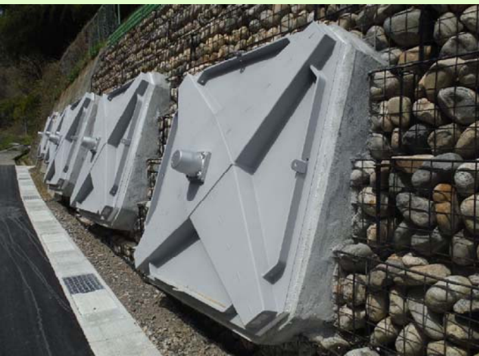
写真3：受圧板設置完了
