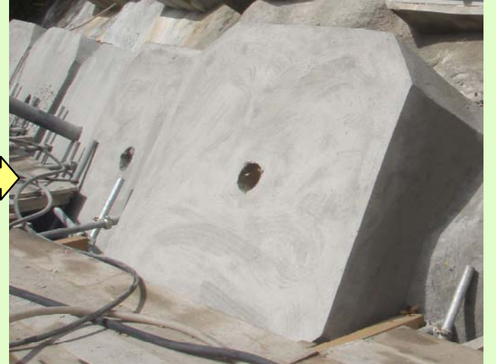
写真4：モルタル吹付完了
