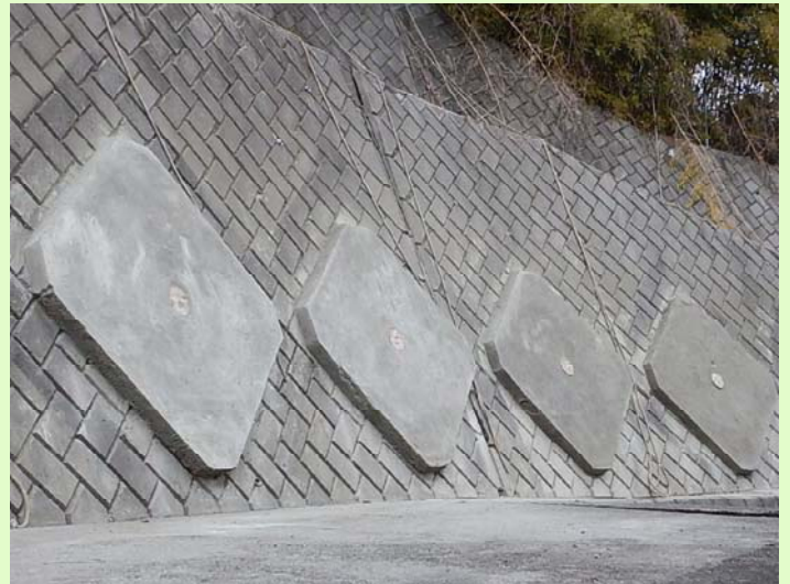
写真2：モルタル吹付完了
