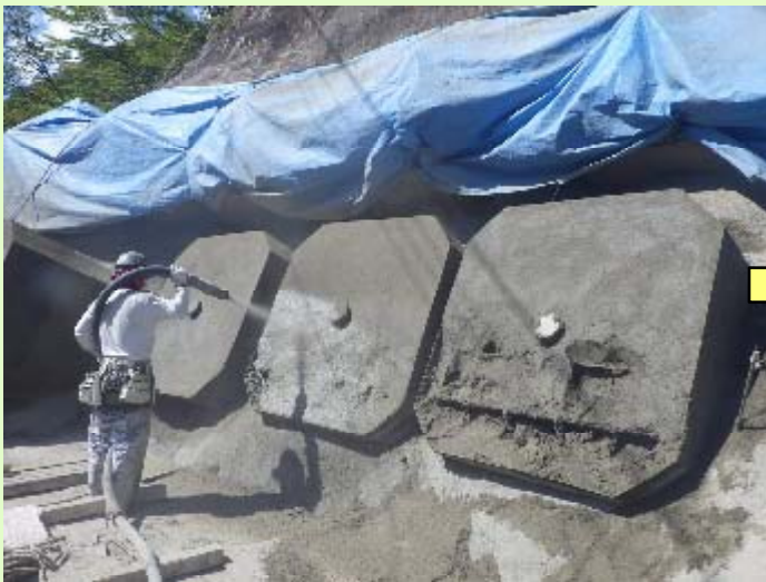
写真3：モルタル吹付状況
