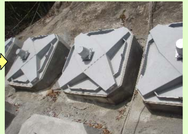
写真6：受圧板設置完了
