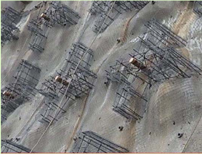
写真1：エフケー不陸調整枠設置
