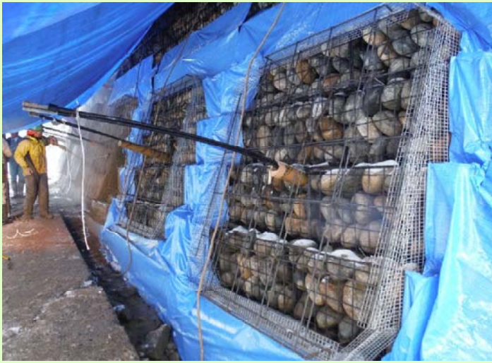
写真1：エフケー不陸調整枠設置
